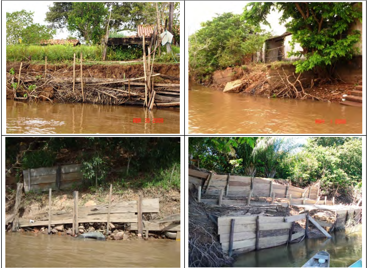
Figura 3. Exemplo de métodos de contenção utilizados na tentativa de conter o desbarrancamento com uso de paliçada, concreto e madeira. (Fotos superiores de 30/4/2008 e inferiores de 6/7/2011).
